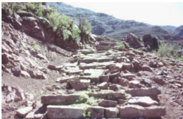
Fig. 7.8 Detalle de construcción del camino que va hacia el río Cachi Mayu
