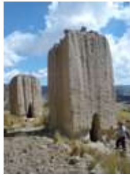
Figura 30. Torres funerarias de adobe de Uypaca.
